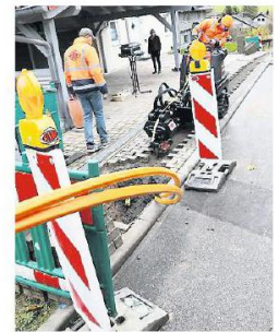
Die dicken Kabel werden bereits am Straßenrand verlegt.
